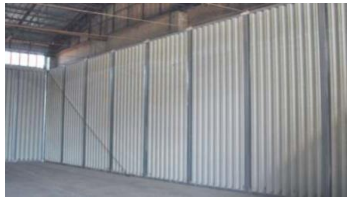
Modulwand abgespannt
