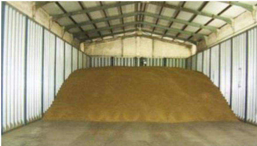
Modulwand um bestehende Halle beschüttbar zu machen
