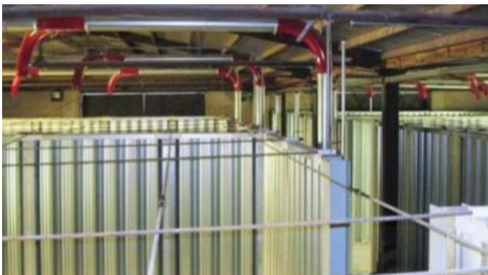
Modulwand Boxen abgespannt
